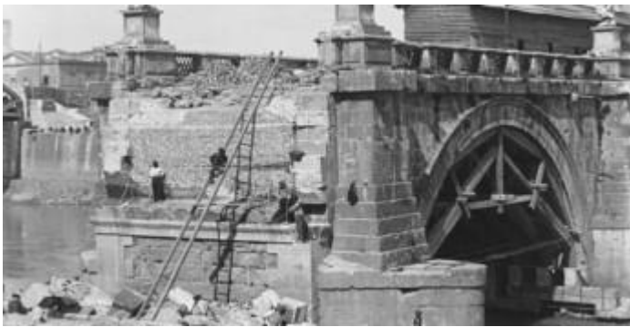
La costruzione dei muraglioni del Tevere (ArchivioFondazione Primoli)
