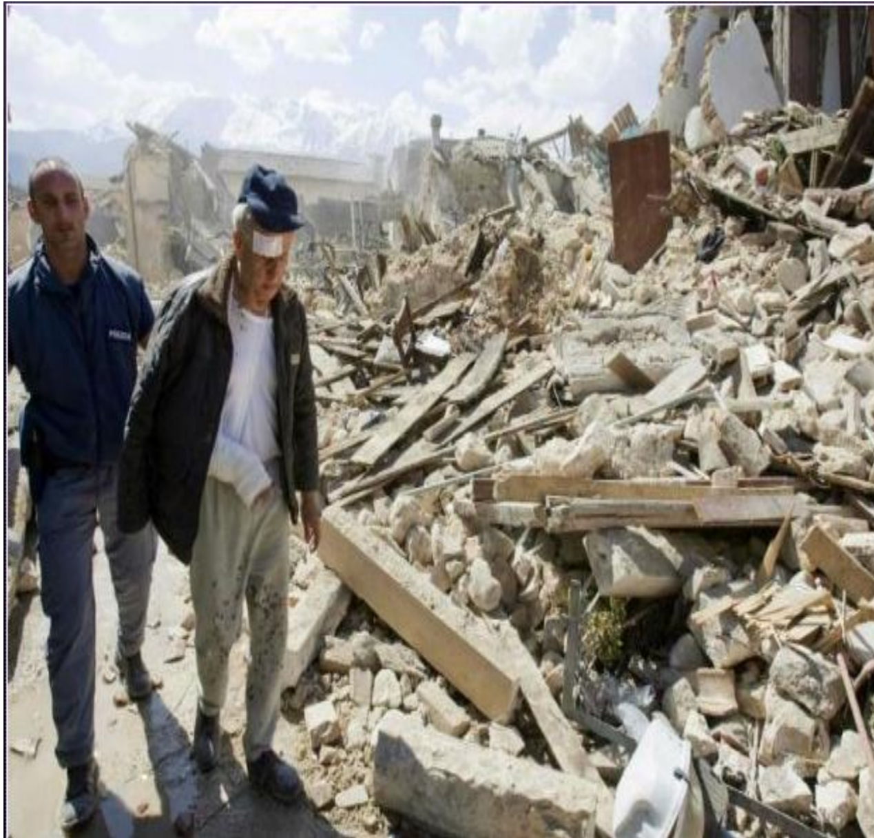
Distruzione totale a Onna, 41 vittime, il 15% degli abitanti
