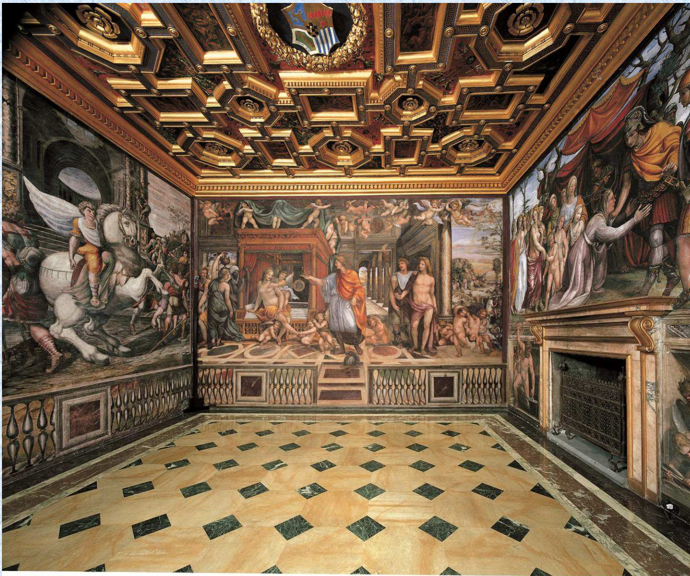
2019. Prima parte dei restauri nella Sala delle Nozze di Alessandro e Rossane, parete est donatore: Double Consulting, Milano-Roma
